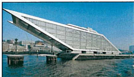
Una fase di cantiere e l'edificio ultimato
